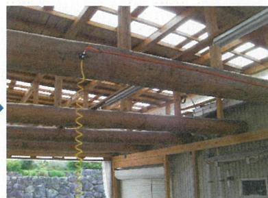
エアホース ロープの置き方・収納によって 作業員の転倒の可能性がある。
